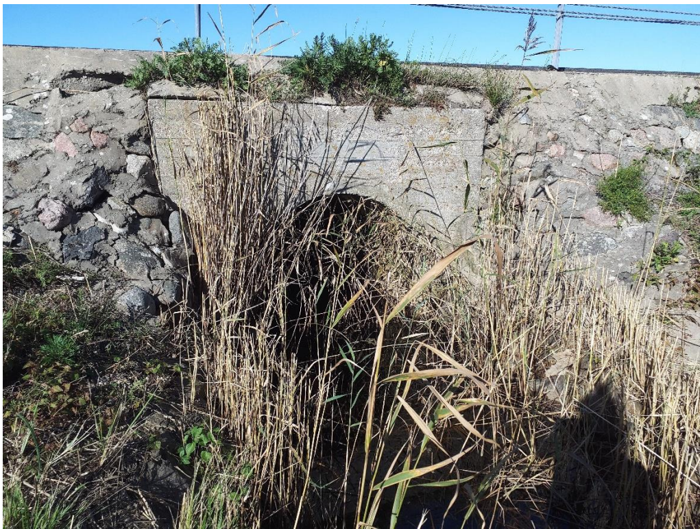
Joonis 4. Voolusängi eeluuringute käigus tuleb anda hinnang Tumala Orissaare Väikese väina tee nr 75 all oleva truubi läbilaskevõimele ja kõrgusele (autor: Anett Reilent 19.09.24).
